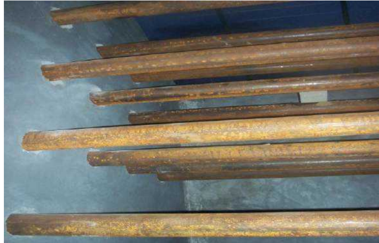
Gambar 3. Pipa Api dalam Ruang Pemanas
